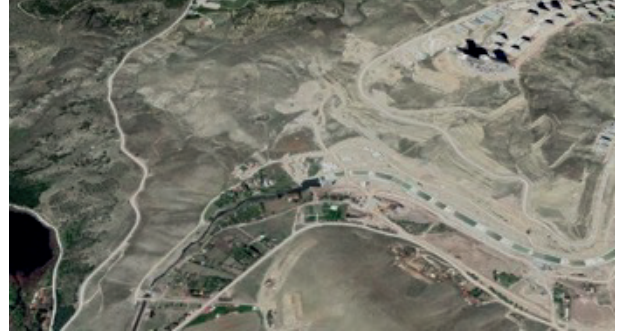
Şekil 7. İmrahor Vadisi Millet Bahçesi uygulaması: İmrahor Deresi yerin altına alınır, üstüne kanal havuz yapılır.
